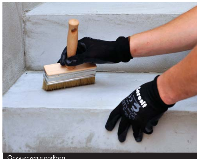
Oczyszczenie podłoża
